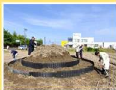
三段花壇の基礎工事
