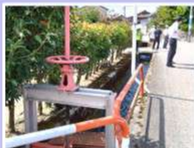
道路面から水路まで深さがあり、 水の流れが速い。
